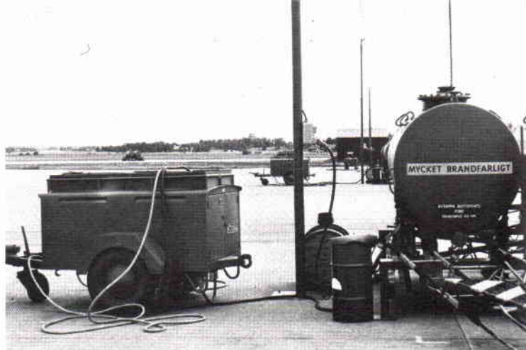
Kraftutttag på stolpen vid uppställningsplatsen på 3 komp. F 16.
