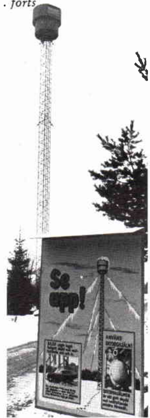
PS 15 lågspaningsradar på en 120 m hög mast och med bensindriven kuggstångshiss.
